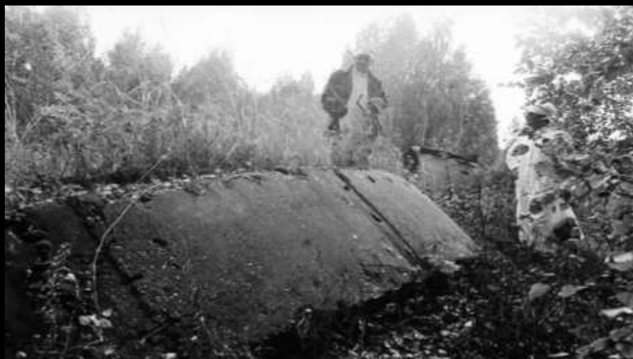
Бетонные перекрытия хранилища
